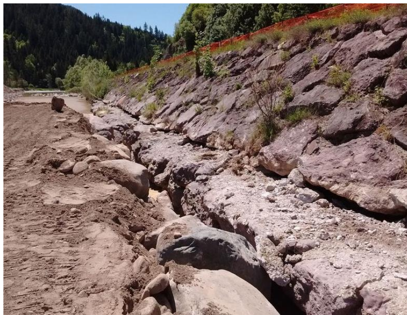
Figura 1-21 - Immagine di dettaglio scogliera in massi intasati con terra
